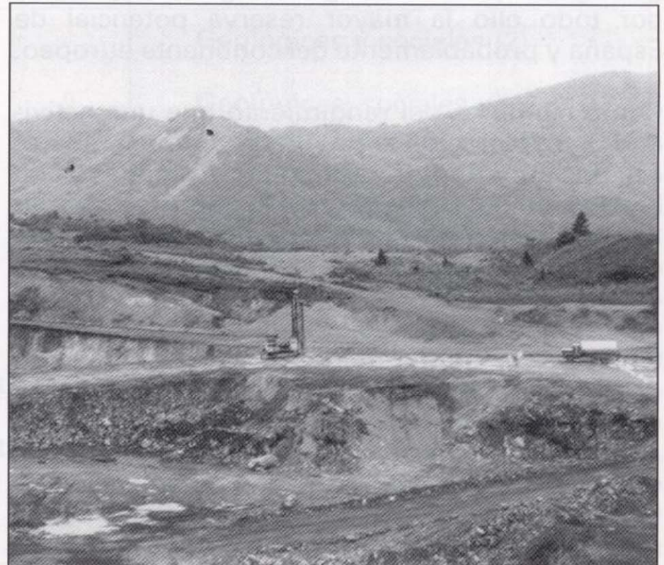
Explotación de Sulfuros Masivos
